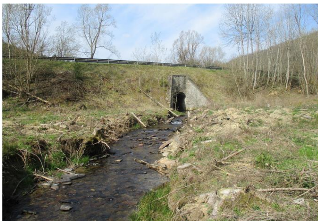
Foto gegen Fließrichtung
