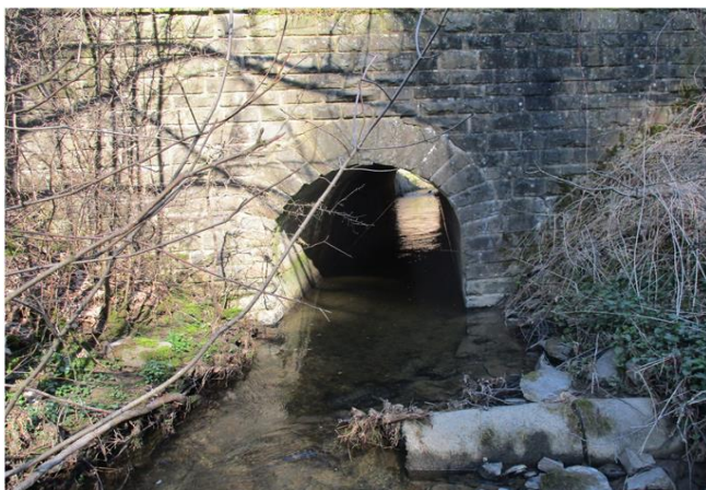
Foto gegen Fließrichtung
