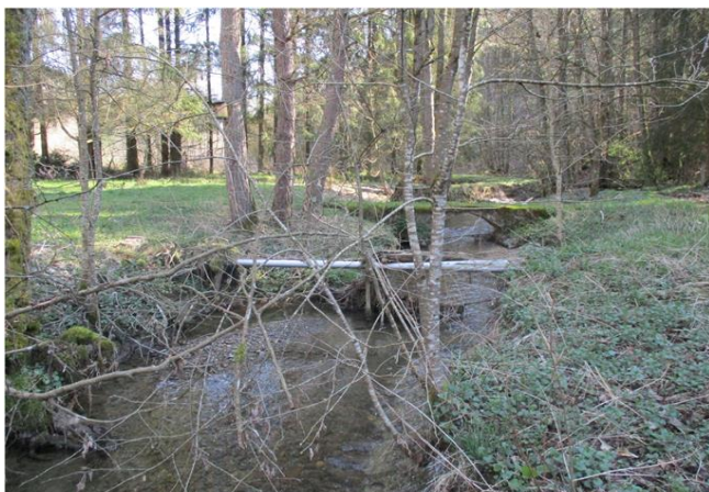
Foto gegen Fließrichtung
