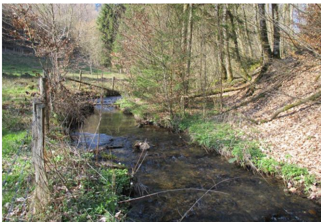
Foto gegen Fließrichtung
