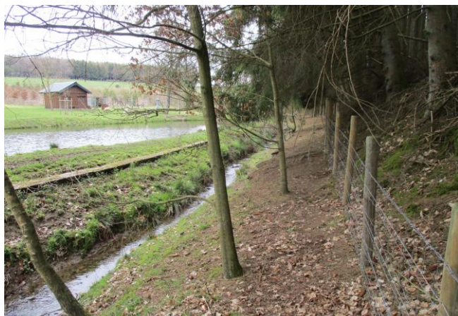
Foto gegen Fließrichtung
