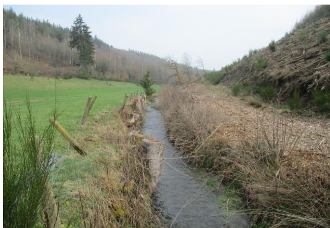
Foto gegen Fließrichtung
