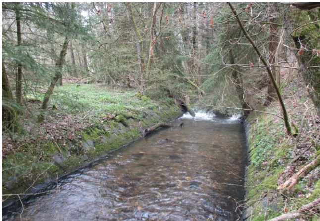
Foto gegen Fließrichtung
