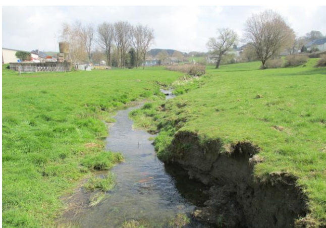
Foto gegen Fließrichtung
