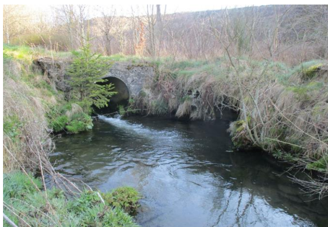
Foto gegen Fließrichtung
