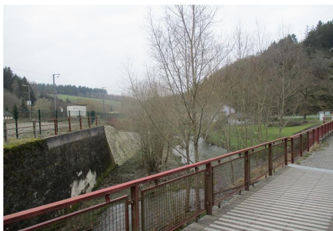
Foto gegen Fließrichtung
