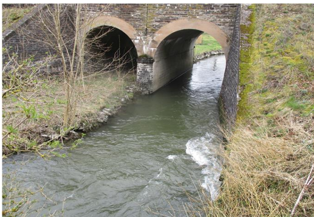
Foto gegen Fließrichtung
