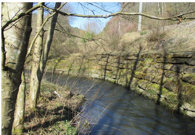
Foto gegen Fließrichtung
