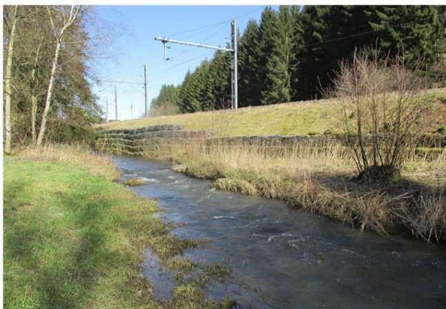
Foto gegen Fließrichtung
