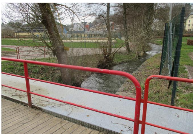
Foto gegen Fließrichtung
