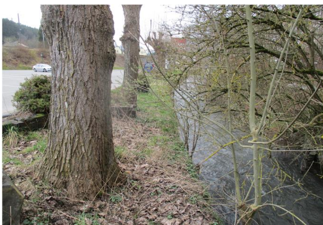
Foto gegen Fließrichtung
