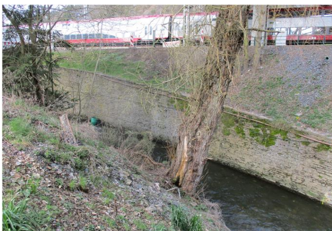
Foto gegen Fließrichtung
