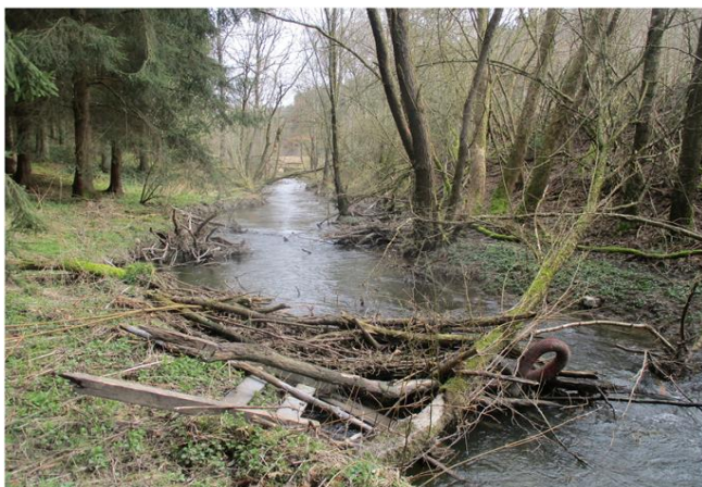
Foto gegen Fließrichtung
