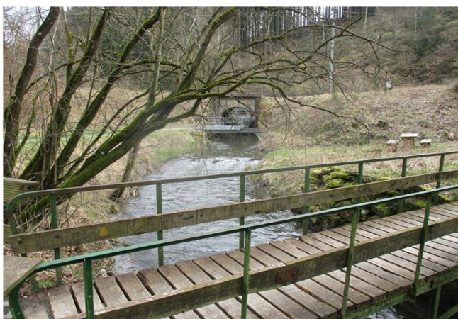
Foto gegen Fließrichtung
