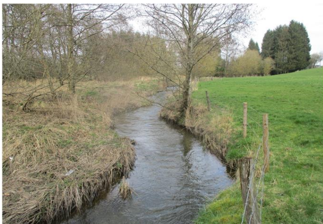
Foto gegen Fließrichtung
