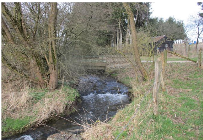
Foto gegen Fließrichtung
