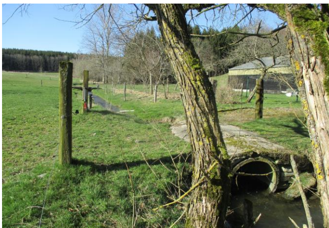
Foto gegen Fließrichtung
