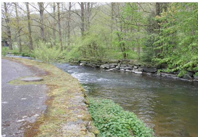
Foto gegen Fließrichtung
