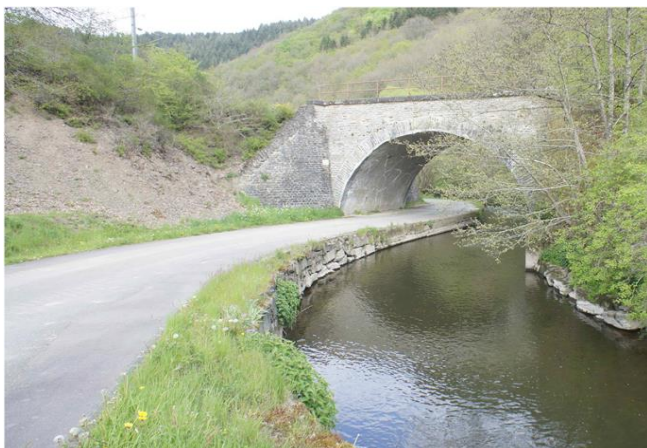
Foto gegen Fließrichtung
