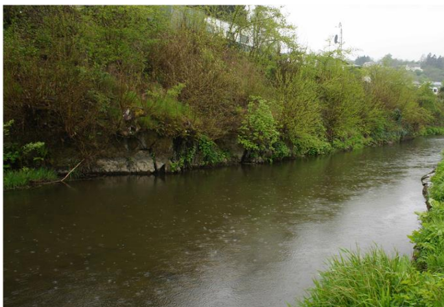
Foto gegen Fließrichtung
