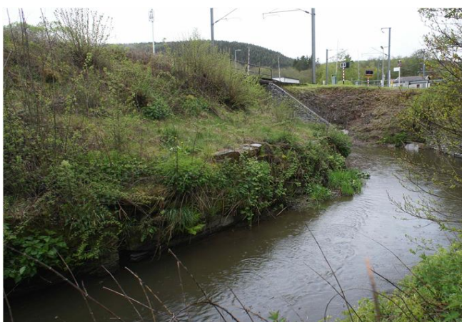
Foto gegen Fließrichtung
