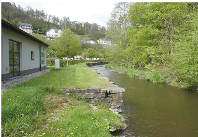
Foto gegen Fließrichtung
