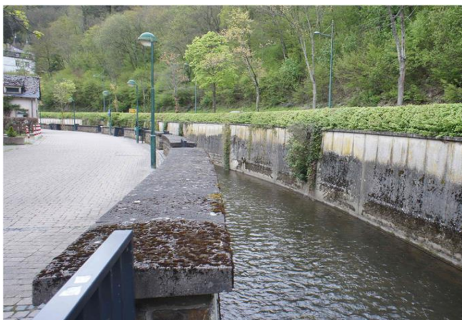
Foto gegen Fließrichtung
