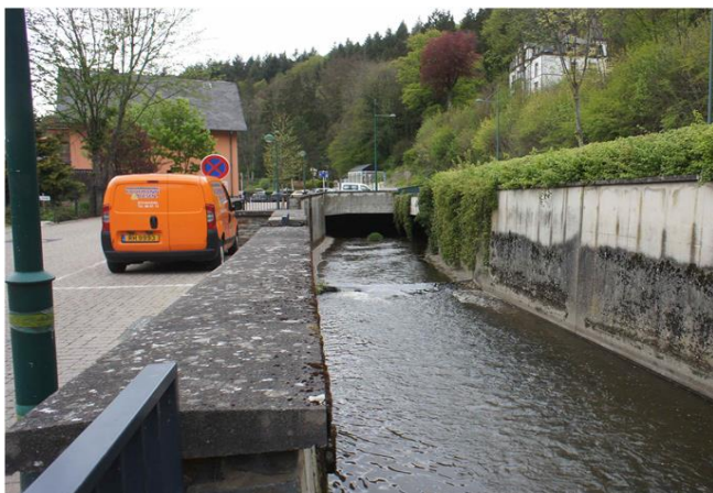
Foto gegen Fließrichtung
