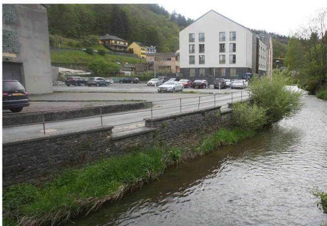
Foto gegen Fließrichtung
