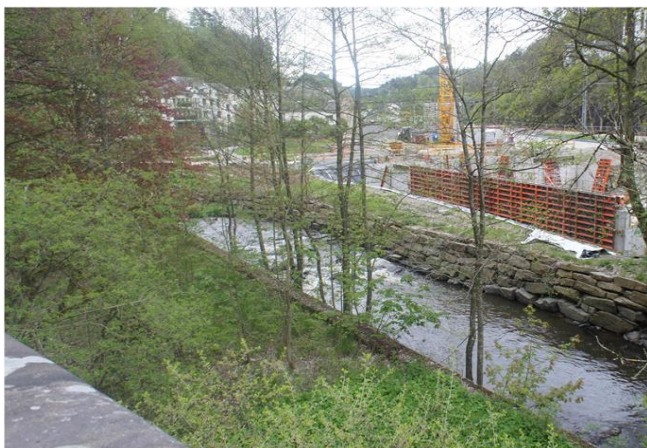
Foto gegen Fließrichtung
