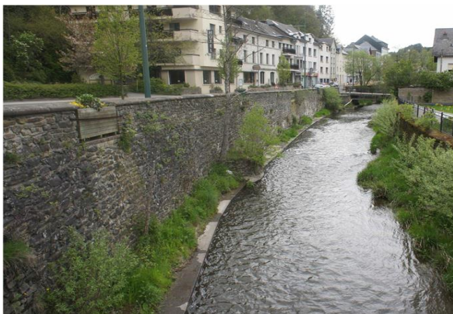
Foto gegen Fließrichtung
