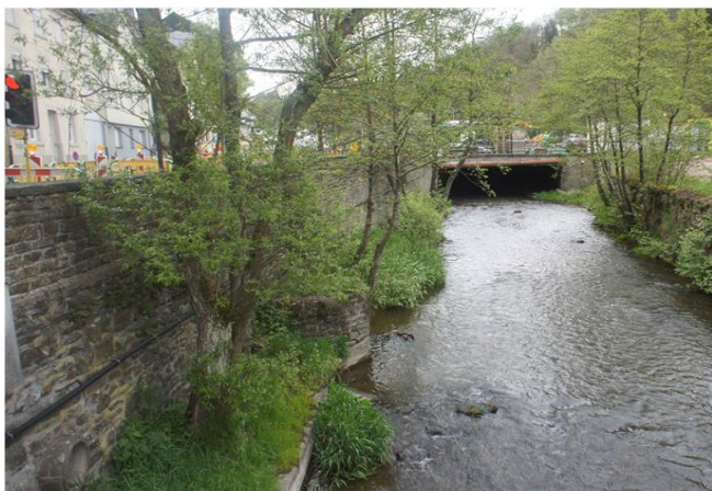
Foto gegen Fließrichtung
