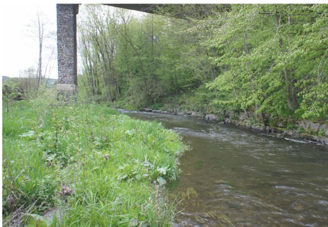
Foto gegen Fließrichtung
