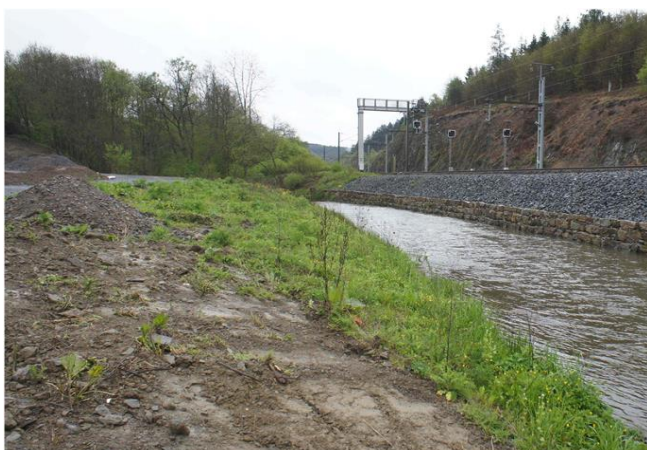
Foto gegen Fließrichtung
