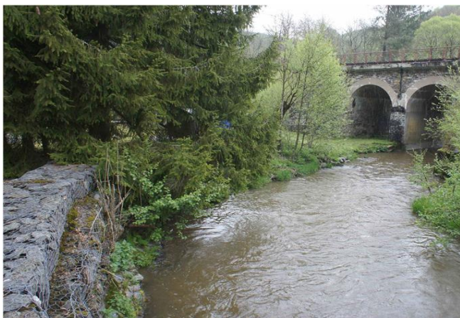
Foto gegen Fließrichtung
