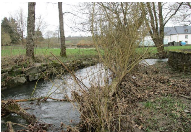
Foto gegen Fließrichtung
