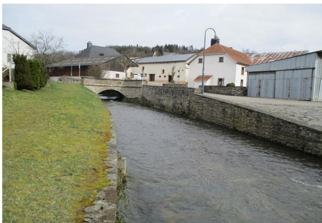
Foto gegen Fließrichtung
