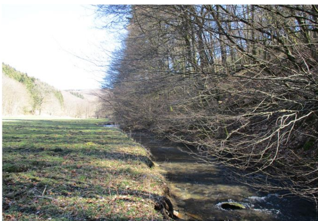
Foto gegen Fließrichtung
