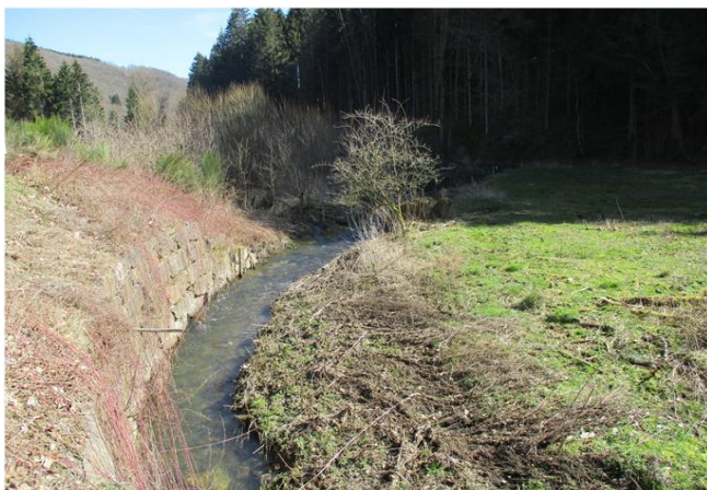
Foto gegen Fließrichtung
