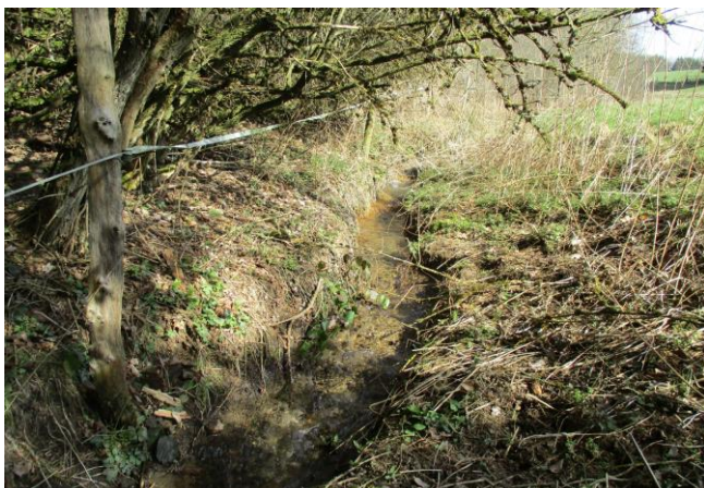
Foto gegen Fließrichtung
