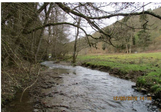
Foto gegen Fließrichtung
