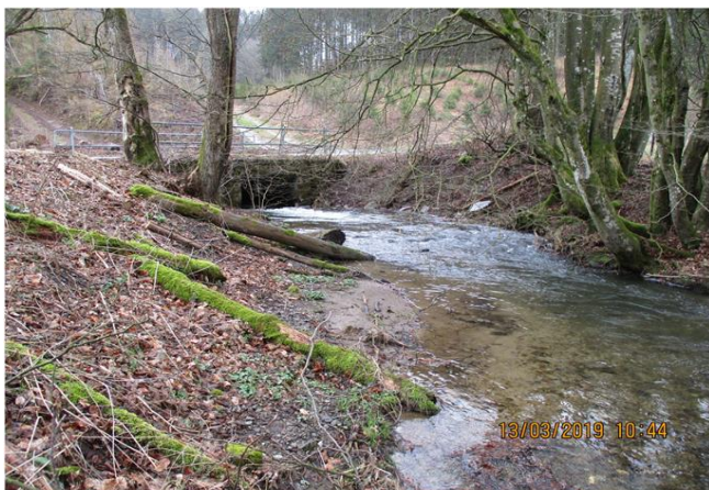
Foto gegen Fließrichtung
