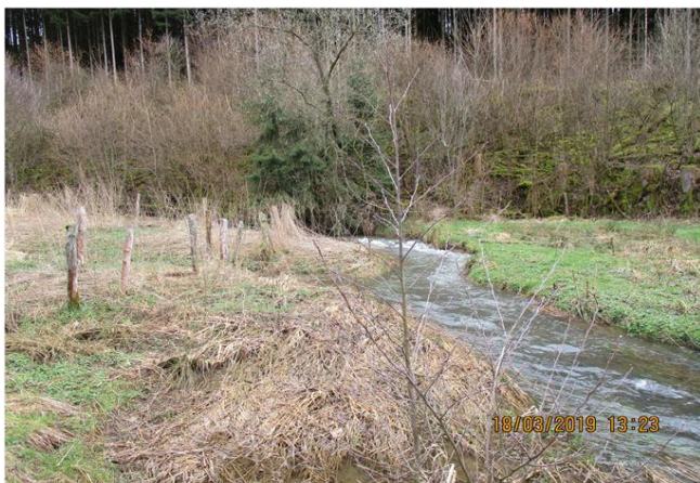
Foto gegen Fließrichtung
