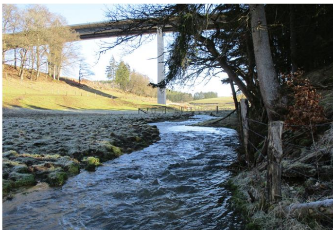
Foto gegen Fließrichtung
