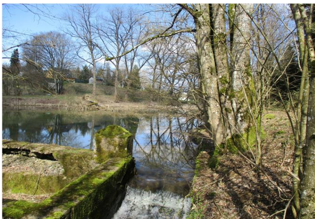
Foto gegen Fließrichtung
