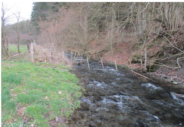
Foto gegen Fließrichtung
