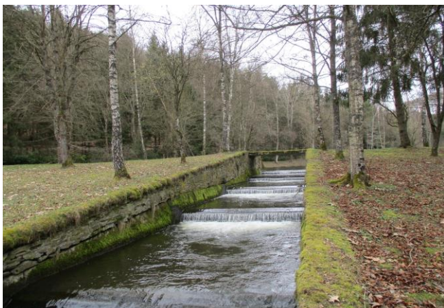
Foto gegen Fließrichtung
