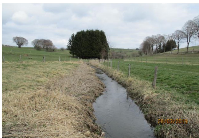
Foto gegen Fließrichtung
