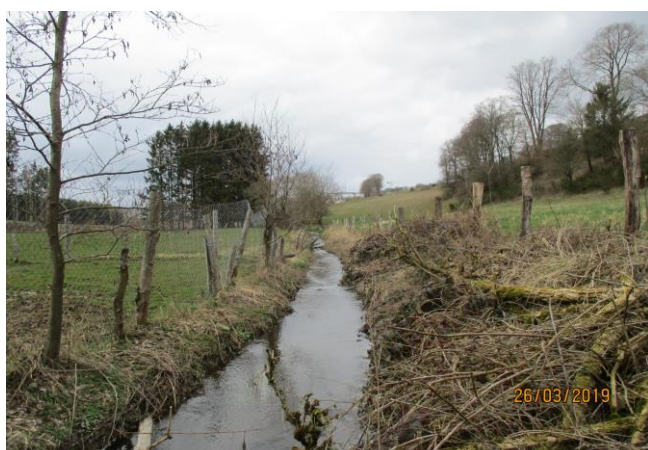
Foto gegen Fließrichtung
