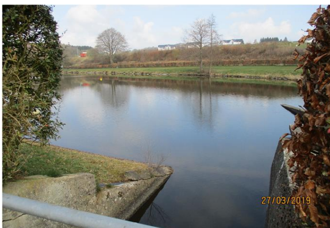
Foto gegen Fließrichtung
